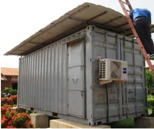
Figure 8: Extérieur du local
